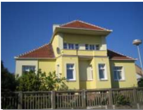
Zateplení RD v Tišnově Výměra: cca. 300m 2 , Systém: Ceretherm Premium Realizace: Jaro 2011, Cena: cca. 300.000,00Kč Investor: majitelé RD Certifikovaný systém pro program zelená úsporám.
