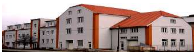
Zateplení objektu fa. Kamoko, Brno - Modřice Výměra: 650m 2 , Systém: Ceretherm Premium, Cena: 1.150.000,00Kč Investor: Kamoko s.r.o., Provedení včetně Tizn. oplechování.
