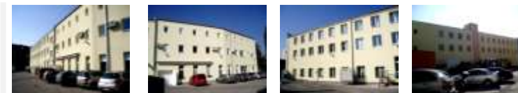
Zateplení objektu Zábřdovická 9 – Holec Production Výměra: 1500m 2 , Systém: Ceretherm Wool Classic, Cena: 1.600.000,00Kč Investor: Stavebik s.r.o., financováno z evropských fondů.
